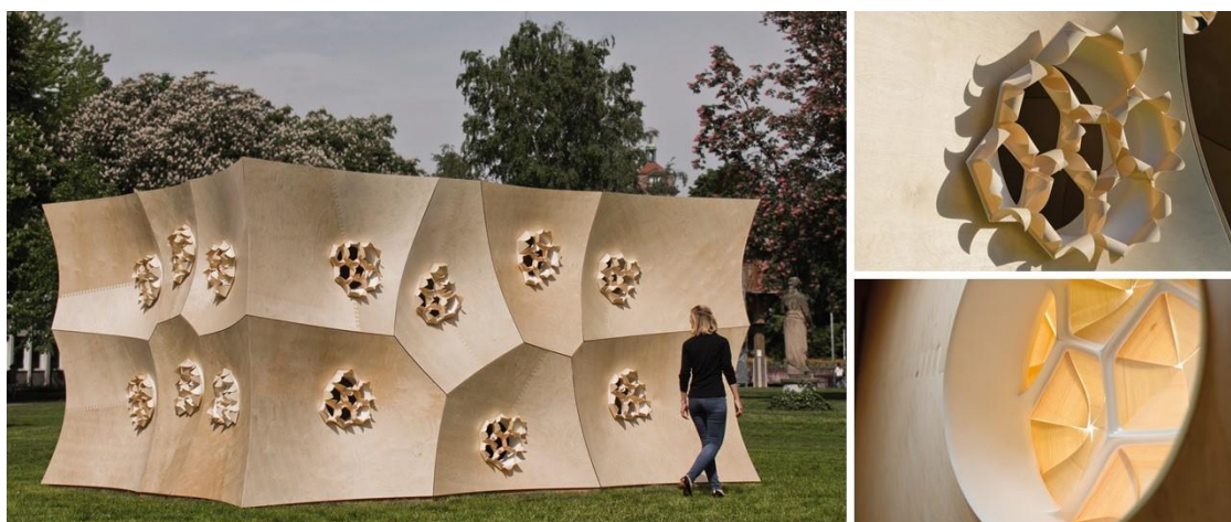
[5] Pavilón HygroSkin a jeho trojuholníkové klapky reagujúce na zmeny počasia [4]
