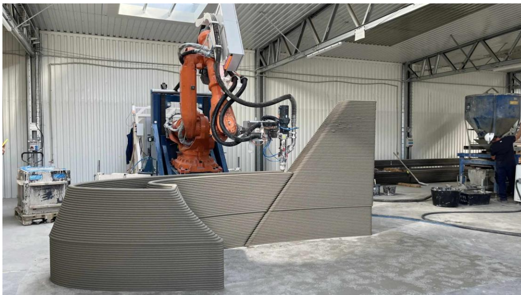
Obr. 7 Tlač zastávky MHD Lipského pomocou robotickej 3D tlače betónu [2.]
