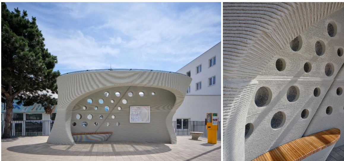
Obr. 6 MHD zastávka Lipského v Bratislave vyrobené pomocou 3D tlače betónu [2.]
